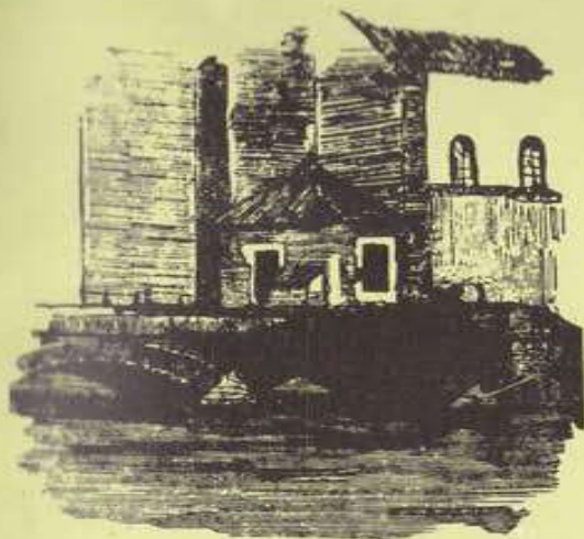
PONTE DE PADRON
