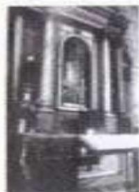
São Roque - Ereira Paroquial
