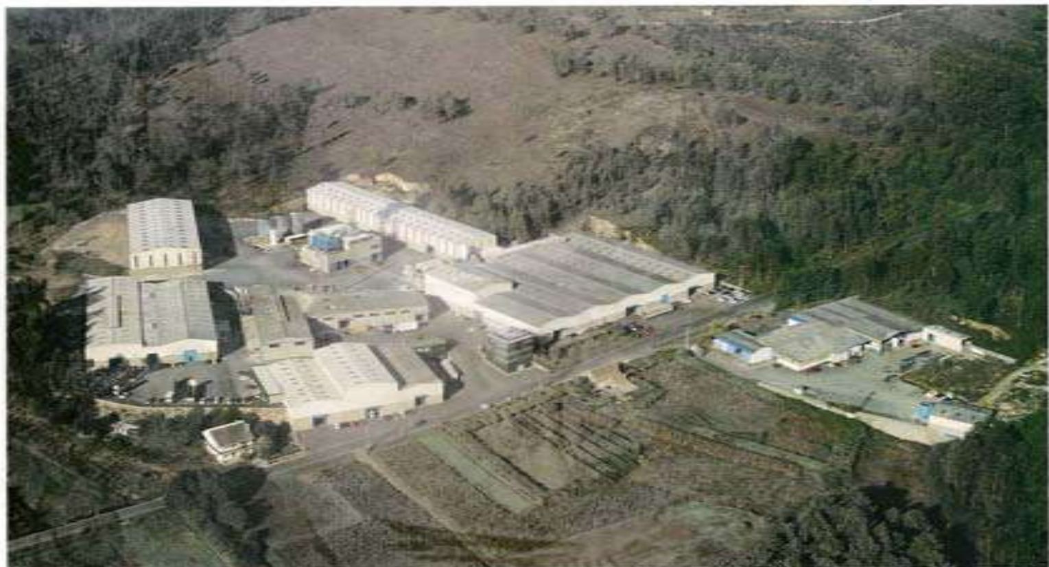
INSTALACIONES DE ALUMINOS CORTIZO EN ENHORÓN (SA CORUÑA)
