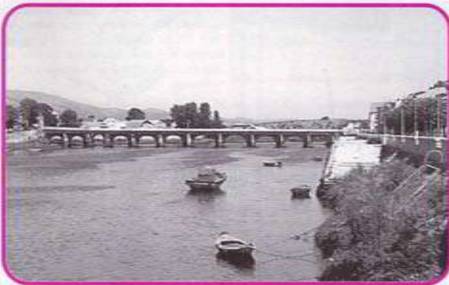
Ponte de Cesures, romana segundo a tradición. No século XII restaurada polo gran Mateo. A Actual é de 1991.
