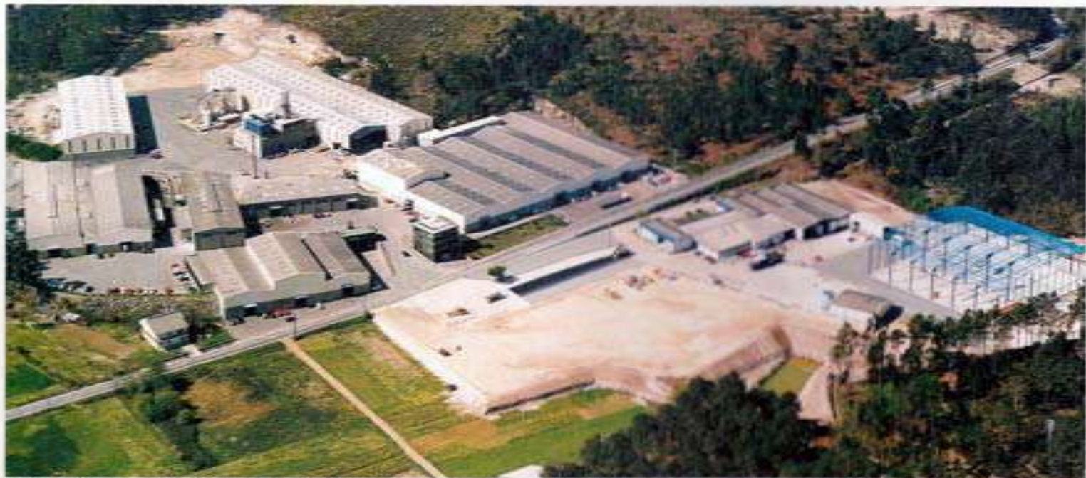
INSTALACIONES DE ALUMINIOS CORTIZO EN PADRÓN (LA CORUÑA)
