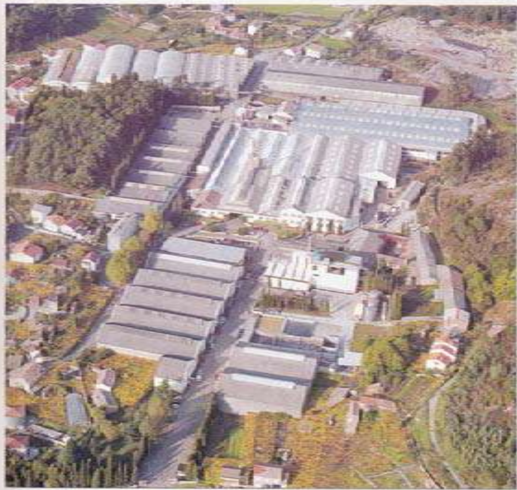
Instalaciones de PICUSA en Padrón (La Coruña - España)
