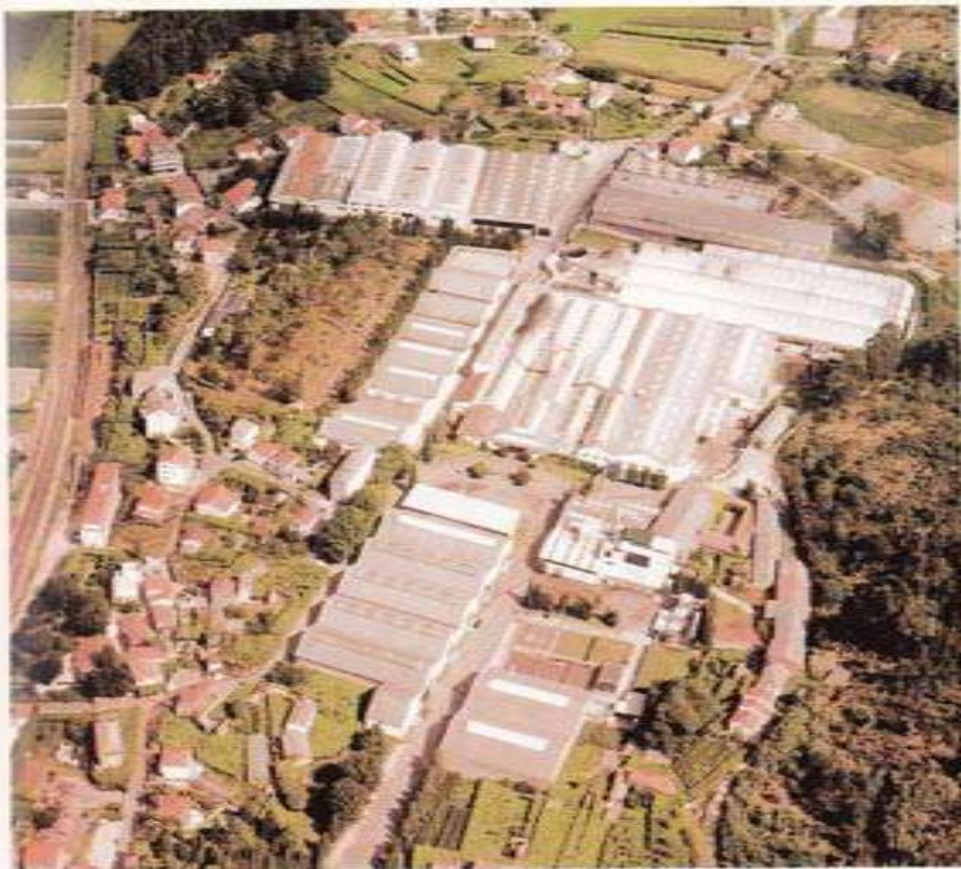
Instalaciones de PICUSA en Padrón (La Coruña - España)
