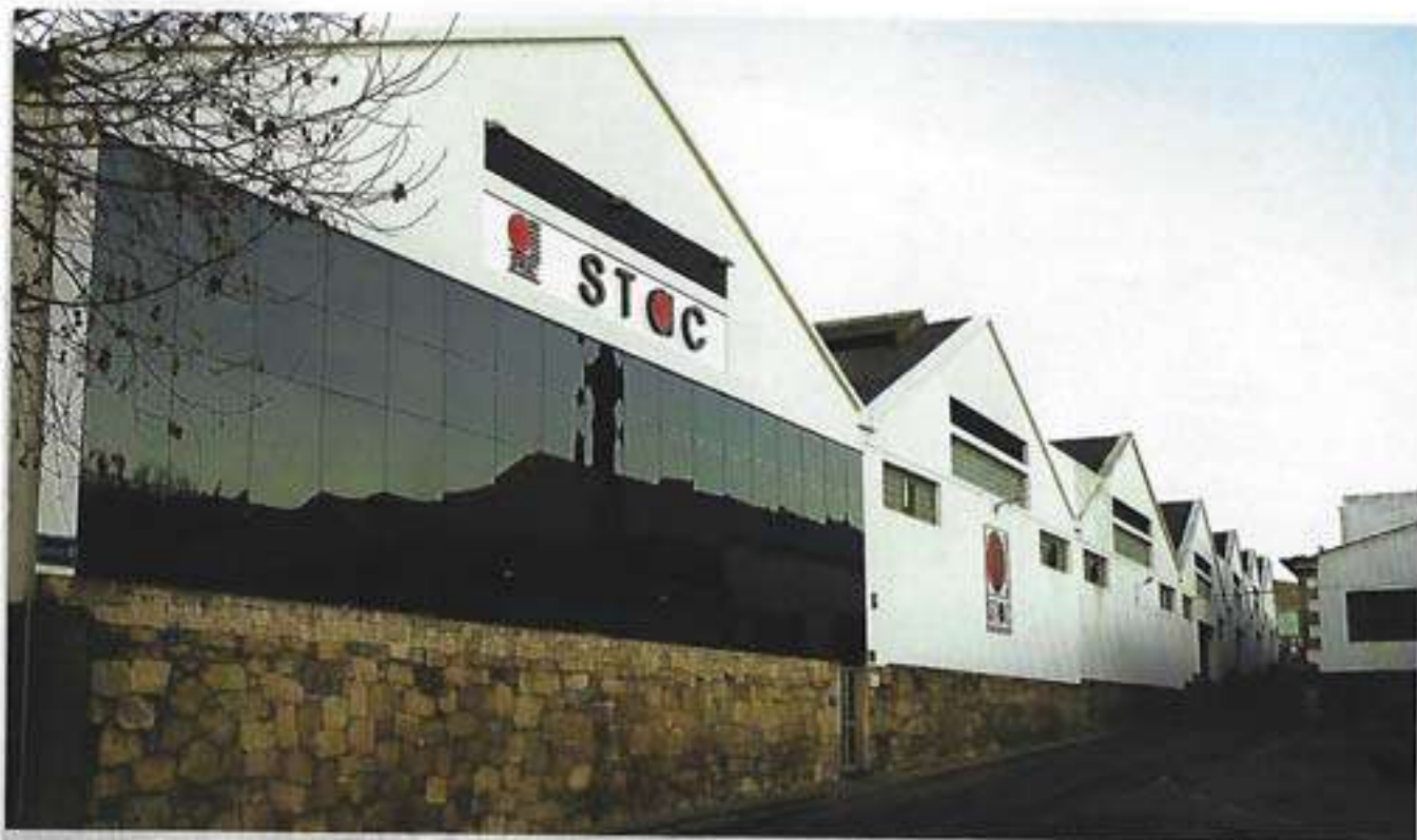
Instalaciones de STAC en Padrón (A Coruña-España)
