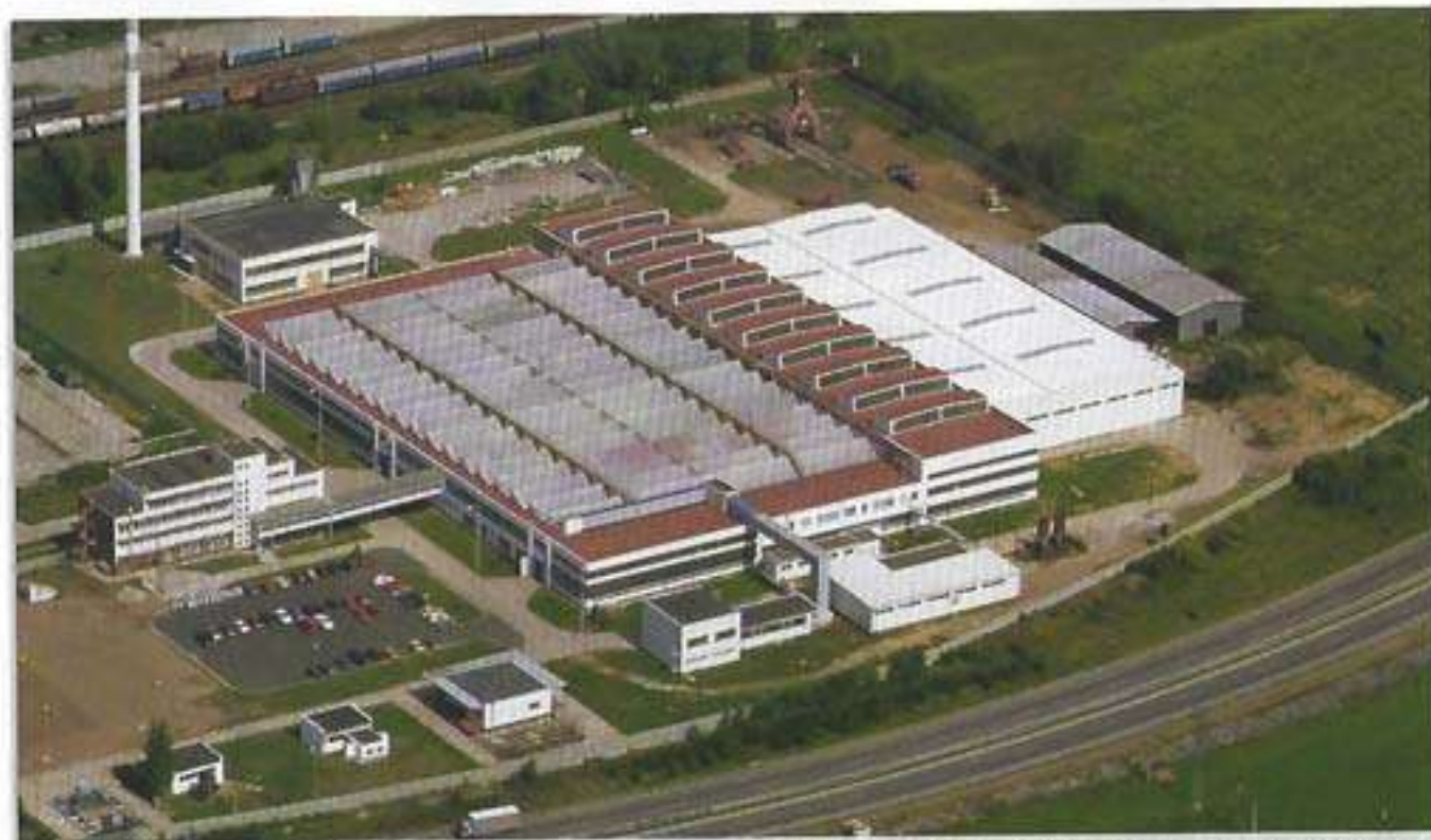
Fábrica y Oficinas Centrales en ESLOVAQUIA
