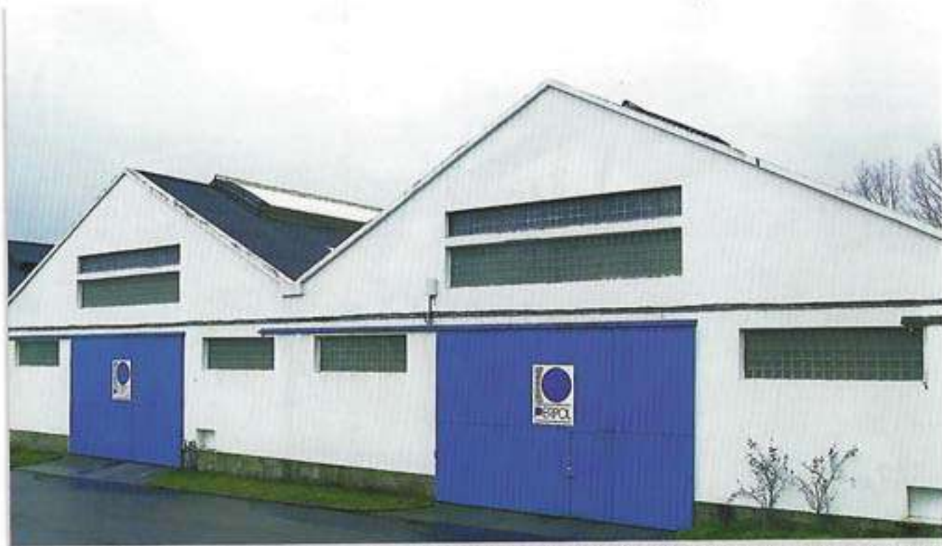
Instalaciones de PERPOL en Padrón (A Coruña-España)
