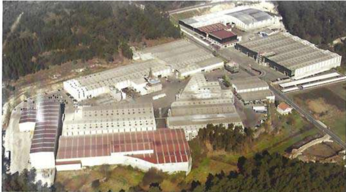
Instalaciones de CORTIZO en Padrón (A Coruña-España)
