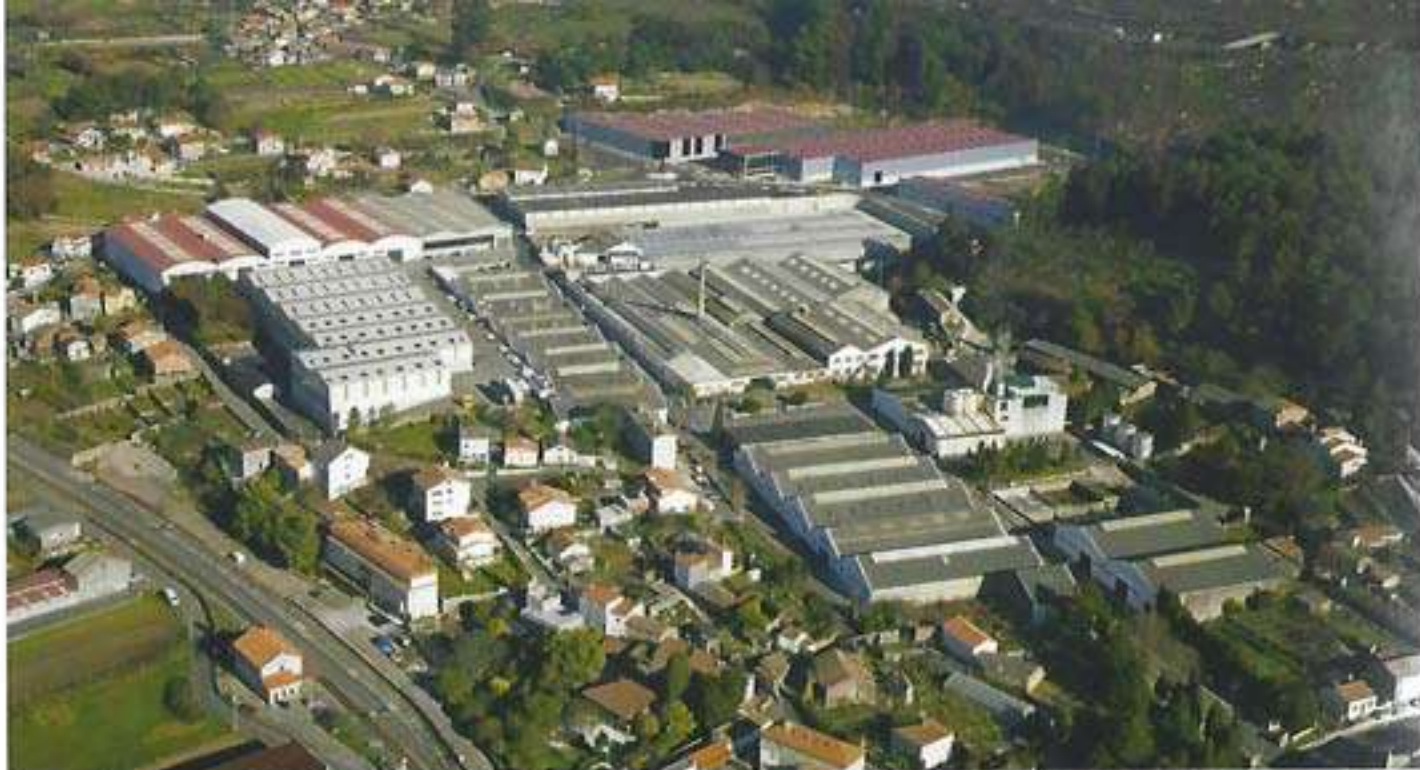
Instalaciones de PICUSA y STAC en Padrón (A Coruña-España)
