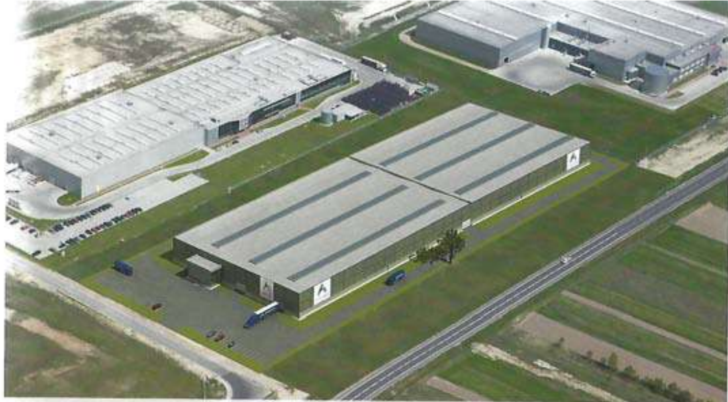
Instalaciones de CORTIZO en Radomsko (Polonia)
